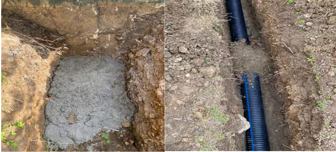
17- P Adası kanalizasyon çalışması başladı. 27.02.2023
